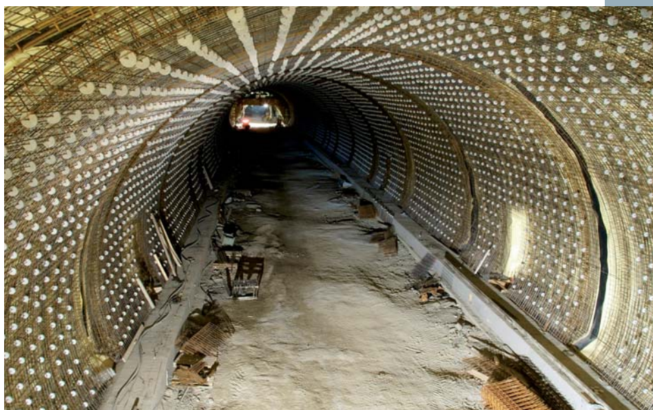
Obr. 5 Samonosná výztuž horní klenby
